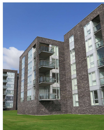
Stanovanjski bloki zasebnega sektorja.
